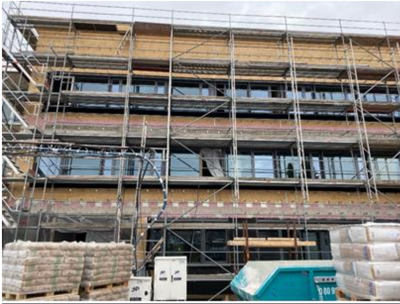
Südfassade, Unterkonstruktion Fassadenplatten
