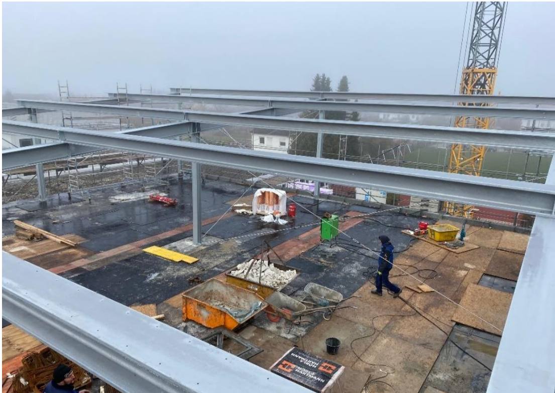
Aufstockung Stahlbau
