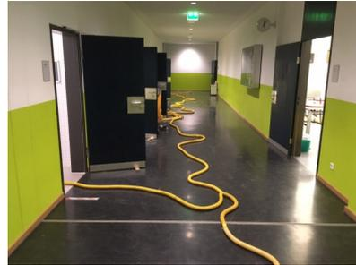
Die technische Trocknung der Estrichdämmschicht wurde am 12.05.2022 umgehend eingeleitet.
