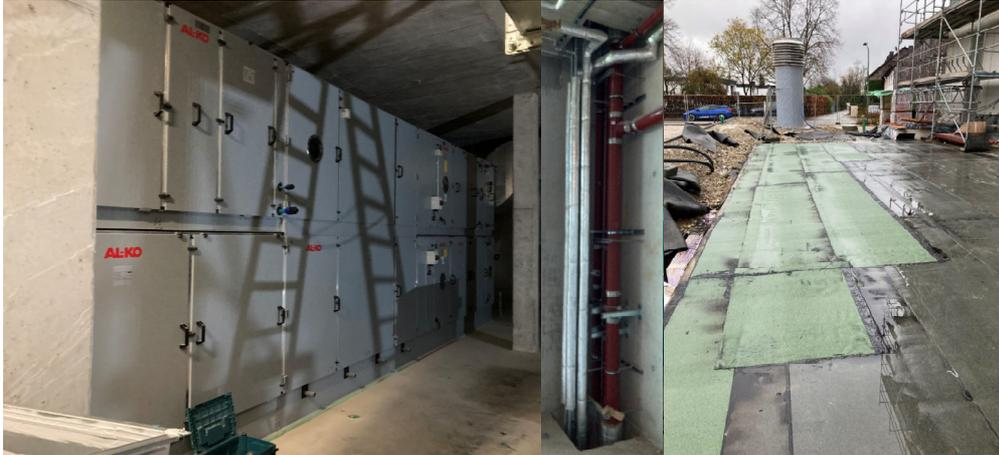
Lüftungszentrale: UG mit Lüftungsgerät – EG mit Abdichtung
