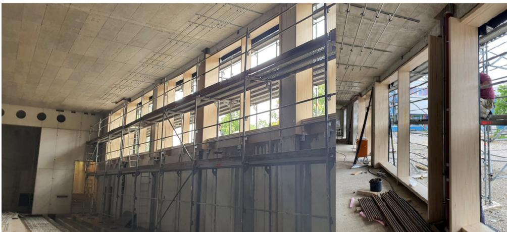
Fassadenarbeiten: Montagebeginn Pfostenriegelfassade
