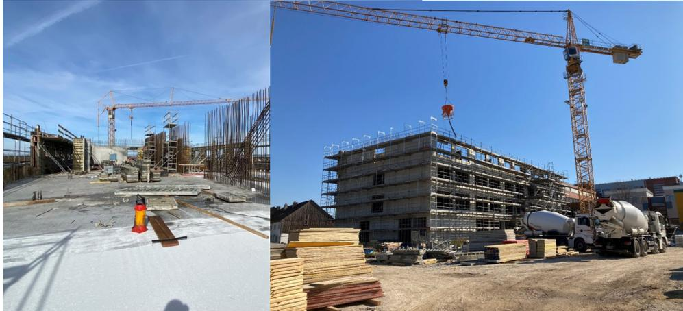
3. Obergeschoß: Wände werden geschalt und betoniert
