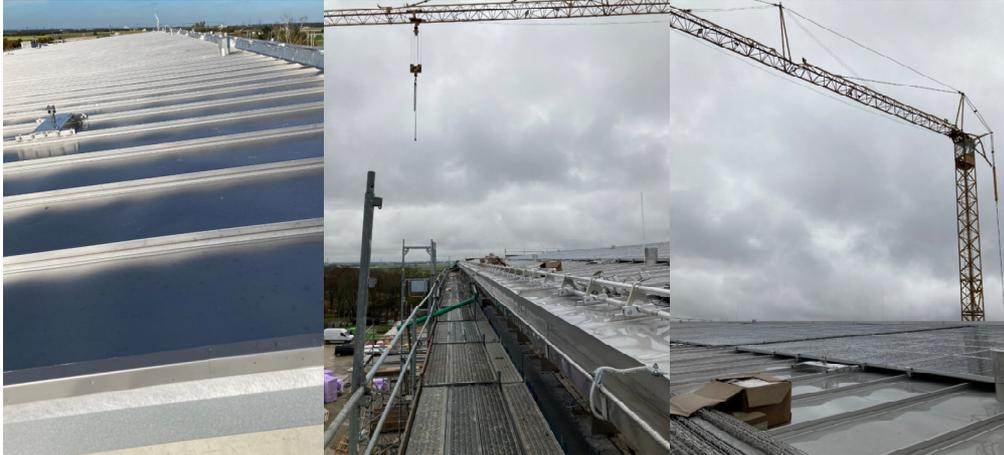
Dach: Edelstahldach geschlossen - PV-Anlage montiert
