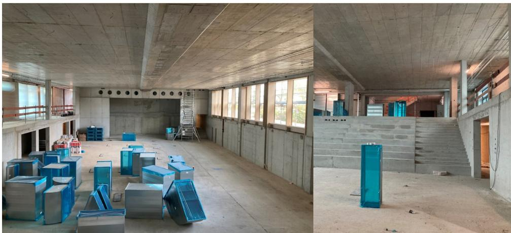
Innenausbau: Bodenkanal geschlossen, Tribünenrohbau fertiggestellt
