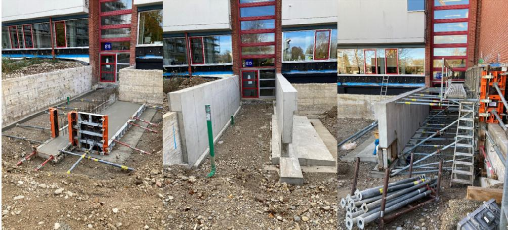
Tiefhof: notwendiger Rückbau Klinker, Betonarbeiten Winkelstützwände
