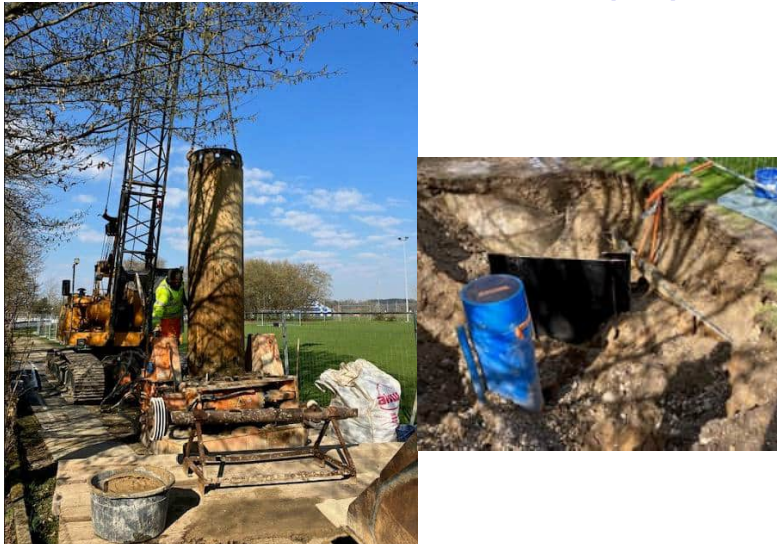
SFZ - Süderweiterung und Umbau am Sonderpädagogischen Förderzentrum Grafing 20.04.2023
