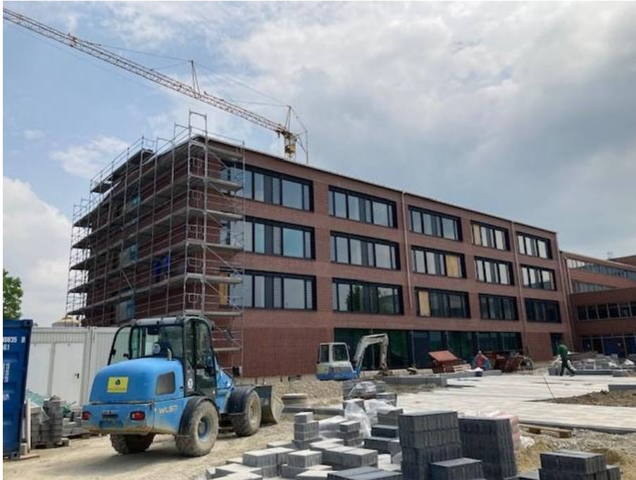
Westseite seit Mitte Mai ohne Gerüst
