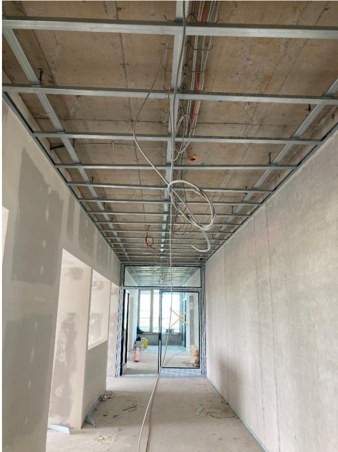
Wandartiger rechts, Betonoberfläche
