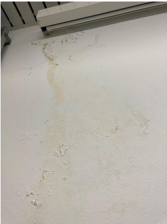
Feuchteschäden an Wand und Stütze im Fachklassenbereich
