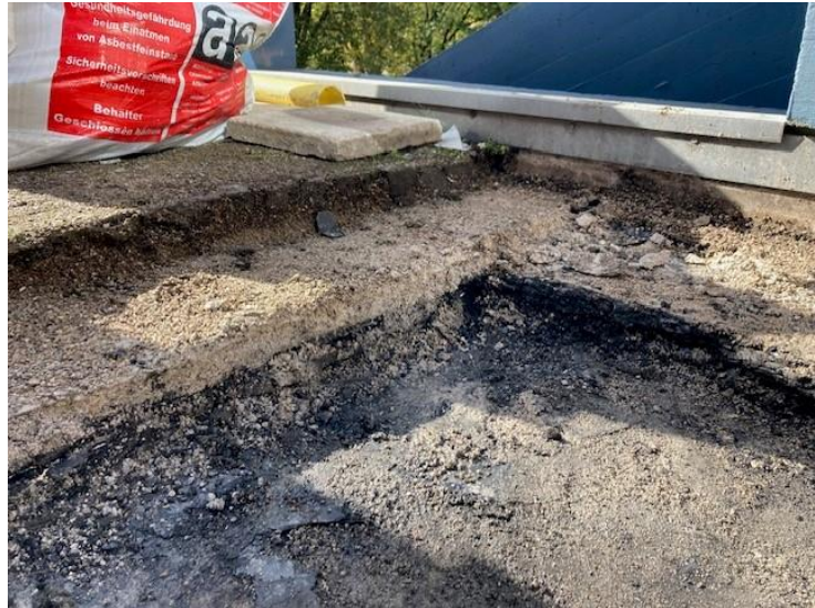
Demontage Dachaufbau Terrasse Süd über UG im Haupteingangsbereich im Zuge der Sanierung Verwaltungsbau, schadhafte bestehende Dachabdichtung
