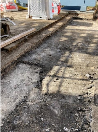
Demontage Dachaufbau Terrasse Süd über UG im Haupteingangsbereich im Zuge der Sanierung Verwaltungsbau, schadhafte bestehende Dachabdichtung
