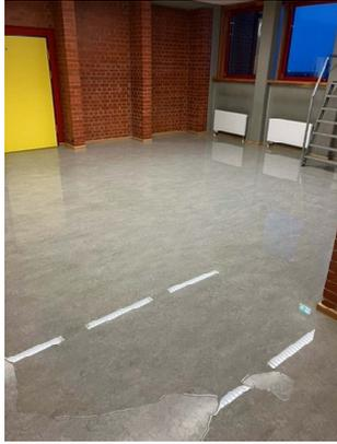
Bild 3: Geschlossene Wasserdecke Flur 3. OG
