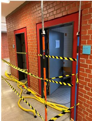
Bild 5: Installation Bautrocknung 3. OG
