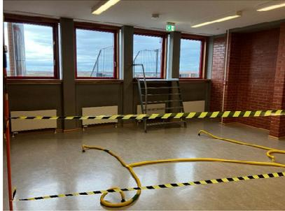
Bild 7: Trocknung 3. OG
